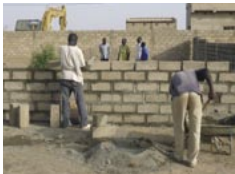
Construction de la « Maison de l'énergie solaire » à Ouagadougou.
