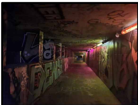
Figure 9 : Sous-voie du Pont St-Georges.
