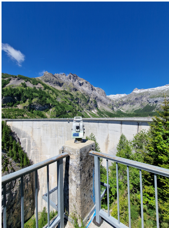
FIGURE 3.16 – Installation de la station totale sur un pilier géodésique
