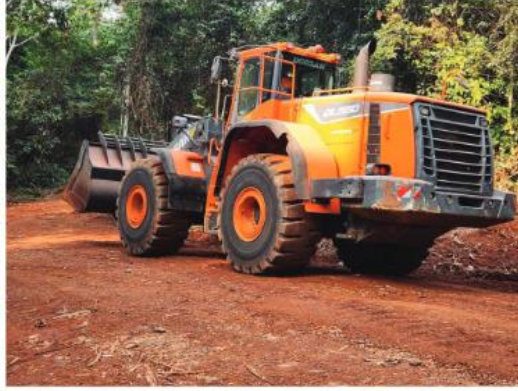
Aménagement des voies d'accès au site
