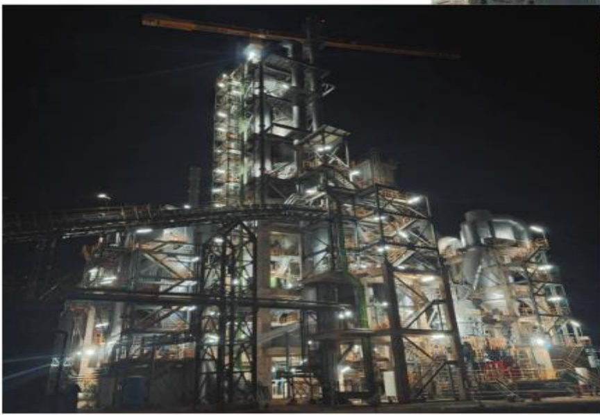
Usine de traitement/transformation
