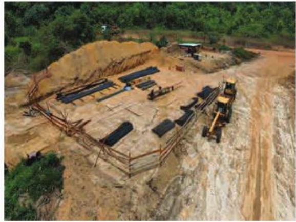
Démarrage des travaux de construction de la base vie
