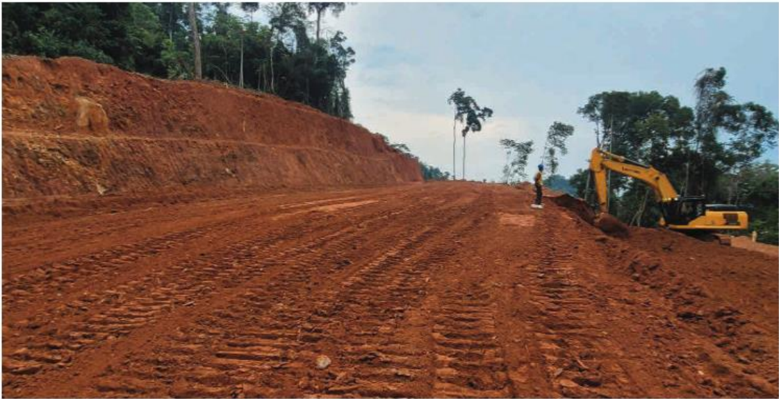
Travaux de terrassement.
