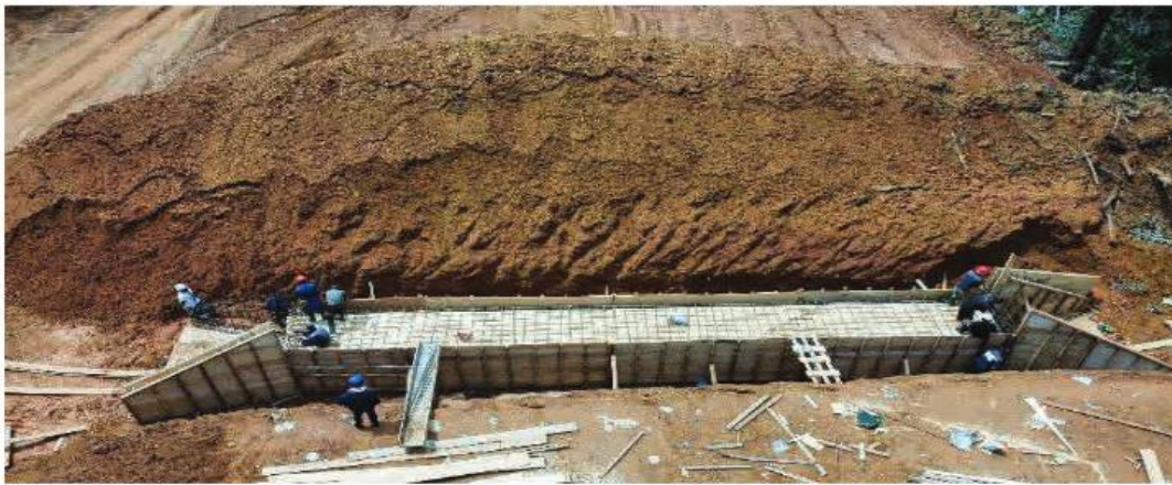
Construction des voies d'accès au site pouvant supporter les engins de 150 tonnes.
