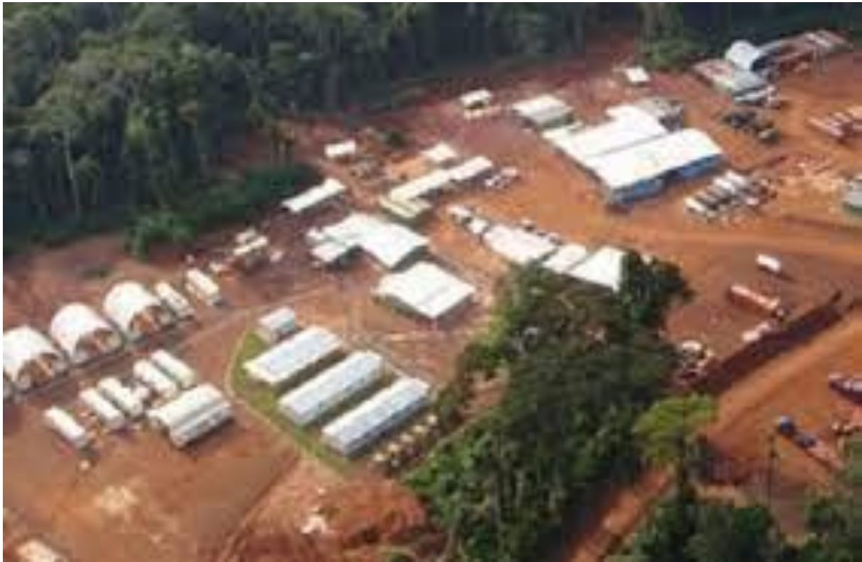
Vue aérienne du chantier minier de Mbalam
