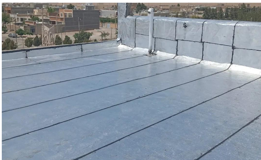
Figure 40: Exemple de toiture à Sanandaj montrant une membrane bitumineuse avec surface aluminisée de type Isogam, pouvant influencer la réponse thermique des surfaces bâties.
