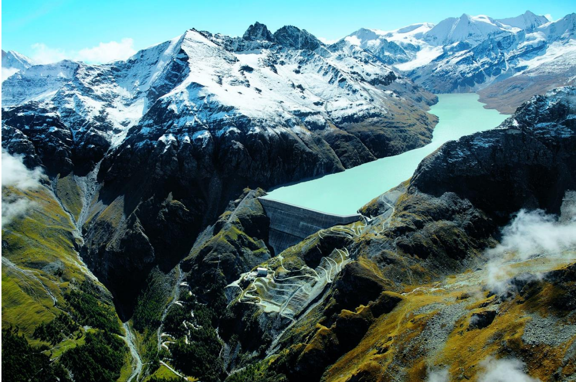
Barrage de la Grande Dixence (source : https://www.valais.ch/fr/activites/excursions/visites-de-barrages/grande-dixence )
