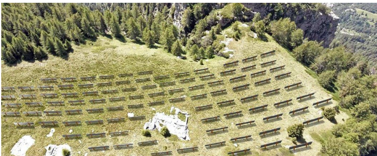
Figure 1 : Exemple d'une grande installation solaire en région alpine, image de synthèse du site de Gondosolar dans le haut Valais (Alpiq, 2023).
